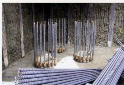
雌型鋼材付ひげアンカー取付完了
