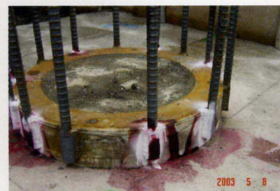
杭頭現場溶接 (従来の工法) (超音波探傷不向き)
